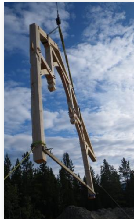
Figure 2 : Montage de la structure en bois d'œuvre
