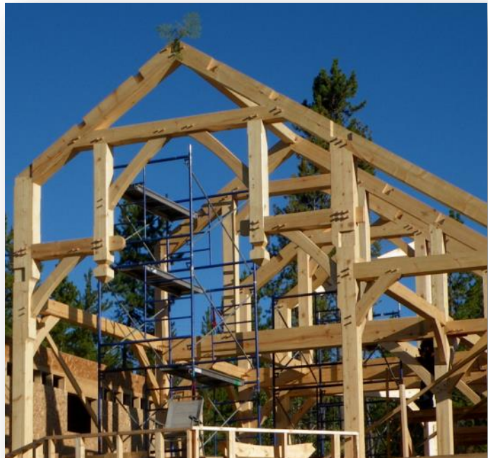
Figure 5 : Structure en bois d’œuvre
